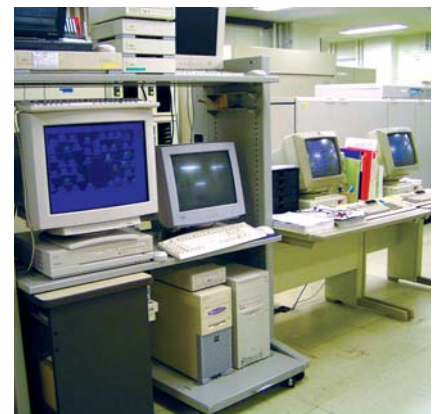
病院情報システム・センターコンピュータ室
